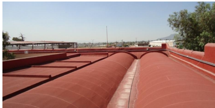
Impermeabilización de azoteas con un total de 4,954.41m 2 . Agosto del 2010.
