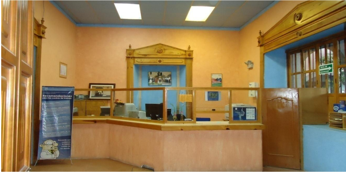
Instalación de 120 lámparas, 32 balastos de 2 x 38 watts que hacen eficiente el consumo eléctrico y visibilidad en el turno vespertino. Octubre del 2010
