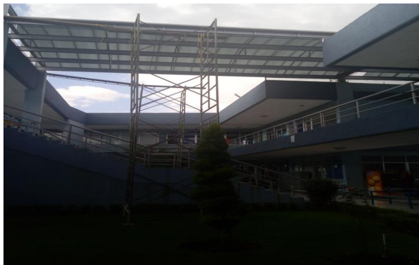
Figura 28. Reparación de domo, edificio principal.
