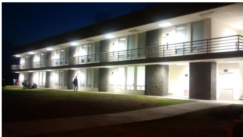
Figura 25. Módulo de aulas, cubículos y site.
