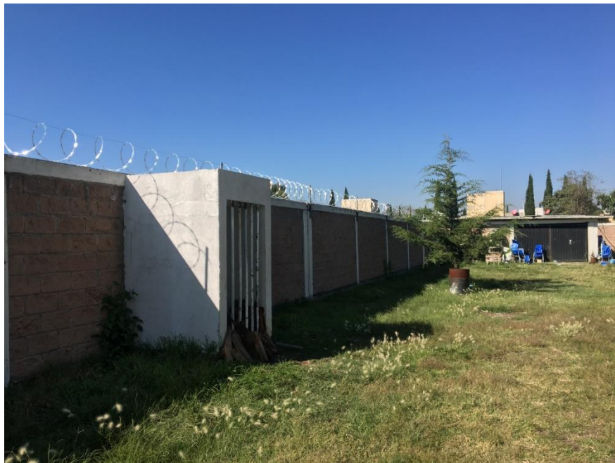
Figura 36. Colocación de concertina en la barda perimetral.
