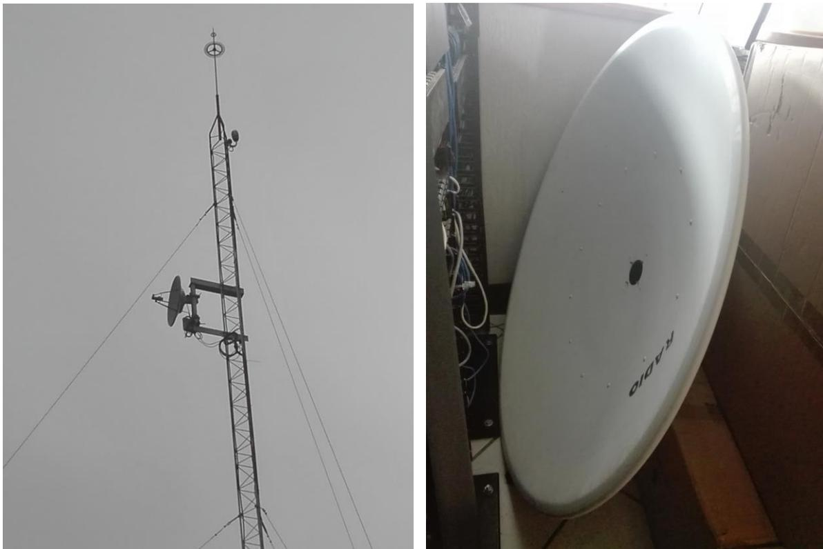
Figura 22. Equipo para enlace de microondas entre el cerro de Santa Ana y Tizayuca
