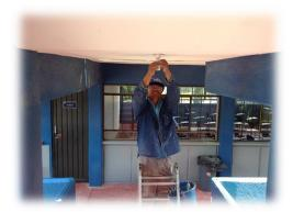
De igual manera, para evitar filtraciones en las instalaciones, se realizó el entortado de los módulos A y B de aulas, además, del laboratorio de ciencias con un total de 913.16 metros cuadrados y la impermeabilización de 1,751 metros cuadrados que es la totalidad de las áreas de esta escuela superior.
