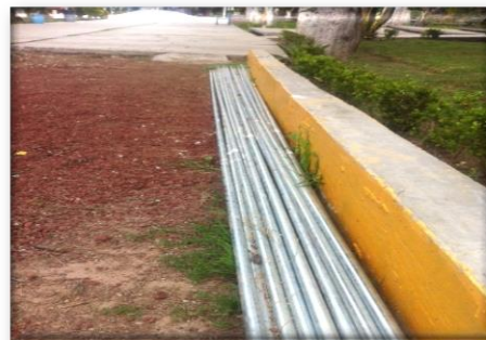
Tubería de la instalación de gas de laboratorios, en mal estado
