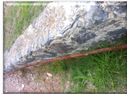
Tubería de la instalación de gas de laboratorios, en mal estado
