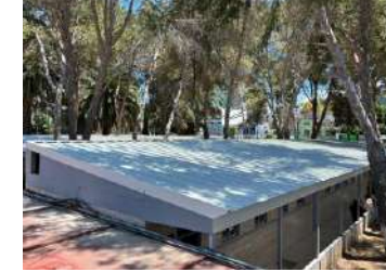
Foto: Conclusión de suministro y colocación de sobre techumbre a base de estructura metálica y lámina galvanizada; y conclusión de trabajos de sustitución de cancelerías (puertas y ventanas)
