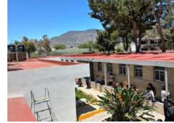
Foto: Conclusión de suministro y colocación de sobre techumbre a base de estructura metálica y lámina galvanizada; y conclusión de trabajos de sustitución de cancelerías (puertas y ventanas)
