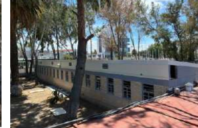
Foto: Conclusión de suministro y colocación de sobre techumbre a base de estructura metálica y lámina galvanizada; y conclusión de trabajos de sustitución de cancelerías (puertas y ventanas)
