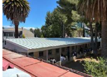
Foto: Conclusión de suministro y colocación de sobre techumbre a base de estructura metálica y lámina galvanizada; y conclusión de trabajos de sustitución de cancelerías (puertas y ventanas)
