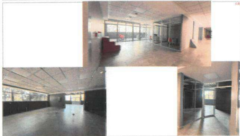
FOTOGRAFÍA 3 (F3). 1er Nivel. Conclusión de instalaciones eléctricas, voz y datos.
