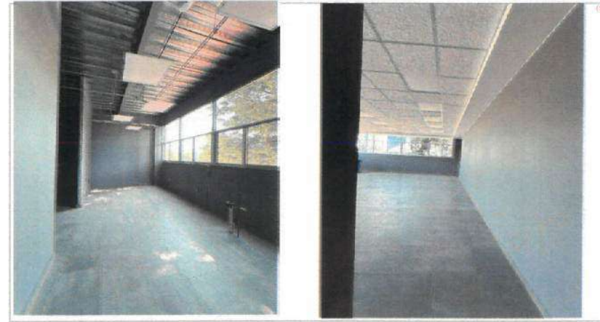
FOTOGRAFÍA 4 (F4). 1er Nivel. Conclusión de trabajos de acabados: aplanados en muros interiores y pintura.
