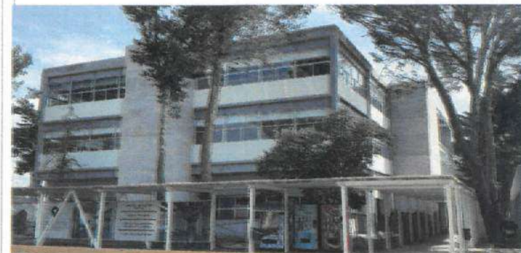
FOTOGRAFÍA ANTES, DURANTE Y DESPUÉS (F5). Foto fachada lateral Suroccidente del edificio, de observan trabajos en segundo nivel.
