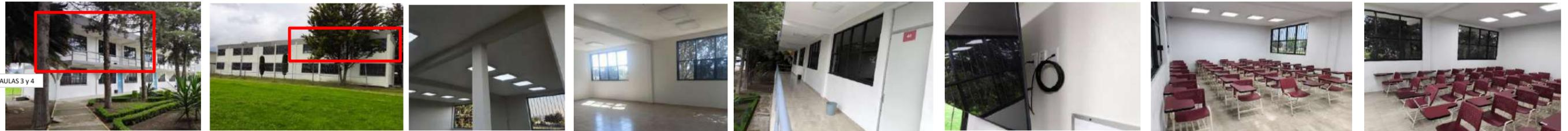
Colocación de pisos cerámicos en interiores de aulas 3, 4 y pasillos; suministro y colocación de pintura en interiores y exteriores planta baja y alta en el espacio que ocupan las dos aulas atendidas; Instalación eléctrica: Suministro y colocación de lámparas y contactos; Cancelería y aluminio.- Suministro y colocación de ventanas en dos aulas, puertas, barandales en pasillo y protecciones.
