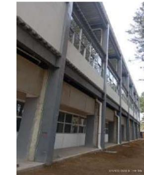
Fotos: Trabajos en fachada 1er nivel: se concluye desplante de muros, repellados, pintura y suministro y colocación cancelería.
