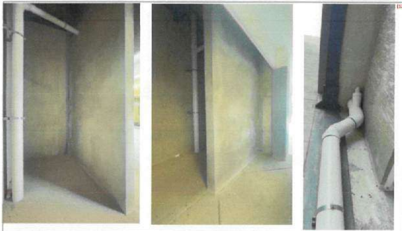
FOTOGRAFÍAS 1 (F1). Continuación de instalación hidro-sanitaria para sanitarios en primer nivel y descargas sanitarias.
