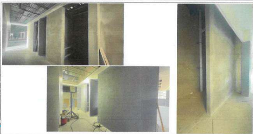
FOTOGRAFIA 4 (F4). Aplanado en muros interiores y pintura.
