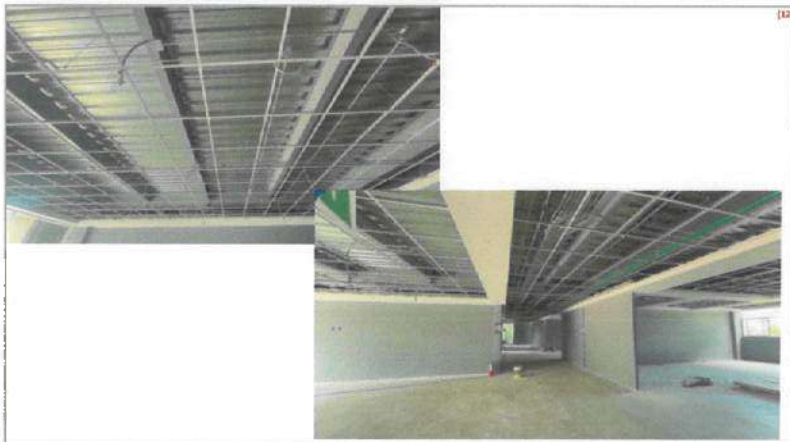
FOTOGRAFIA 3 (F3). Tendido de tuberías en plafón para instalación eléctrica, voz y datos.
