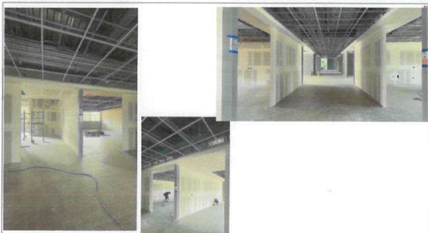
FOTOGRAFIA 2 (F2). Colocación de muros de tablaroca, cancelerías de aluminio, bastidores para plafón y puertas.
