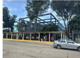
Foto: Habilitado y armado de acero de cubo de servicios
