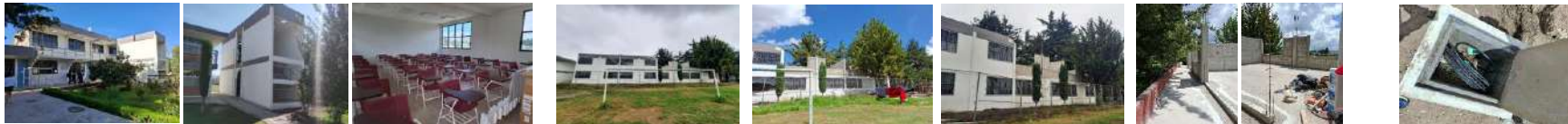
Fotos: 2 Aulas concluidas
