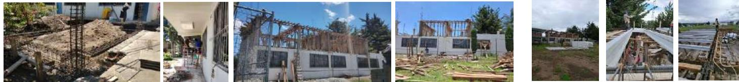
Fotos: Trabajo, nivelación, excavación, cimbrado y armado de acero en cimentación para cubo de escaleras.
