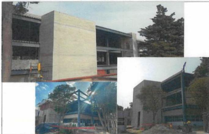
FOTOGRAFIA 1 (F1). Trabajos de colado en cubo de elevador; albañilería en cubos de elevador y escaleras.
