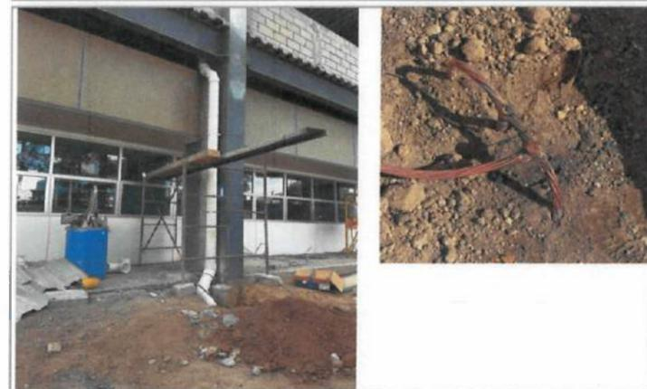
FOTOGRAFIA 4 (F4). Salidas hidrosanitarias (sanitarios) e instalación de tierras.
