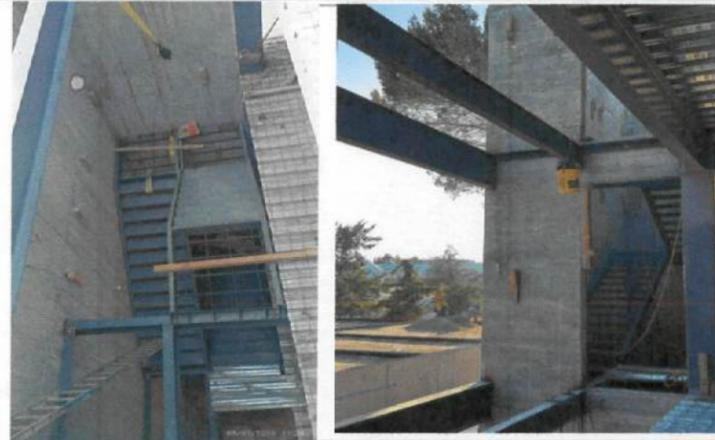
FOTOGRAFIA 2 (F2). Suministro y colocación de escaleras metálicas en cubos de escalera.
