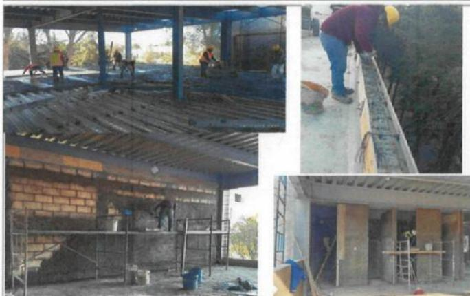
FOTOGRAFIA 3 (F3). Colado de losa tipo losacero; trabajos de albañilería (desplante de muros de block, castillos, cadenas y repellados).
