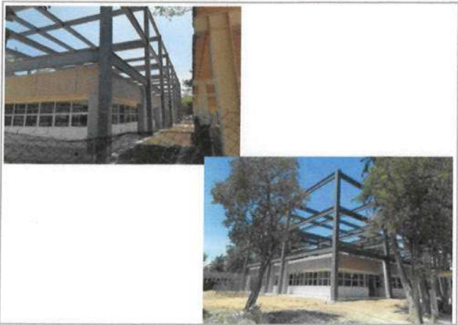
FOTOGRAFIA 1 (F1). Estado actual del edificio, Perspectiva fachada principal (Sur y Este y Sur Oeste).
