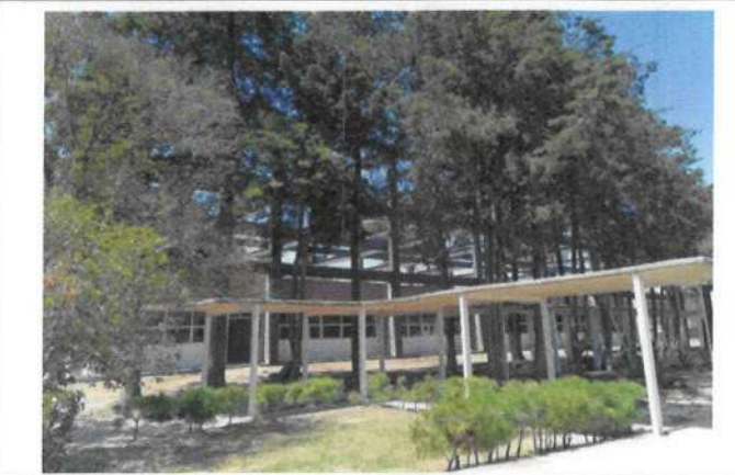
FOTOGRAFIA 4 (F4). Estado actual del edificio, Fachada Noroeste.
