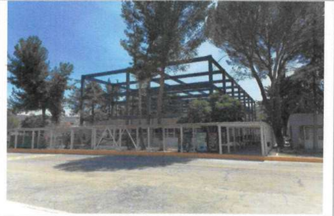
FOTOGRAFIA ANTES, DURANTE Y DESPUÉS (F5). Foto fachada lateral Suroeste del edificio.
