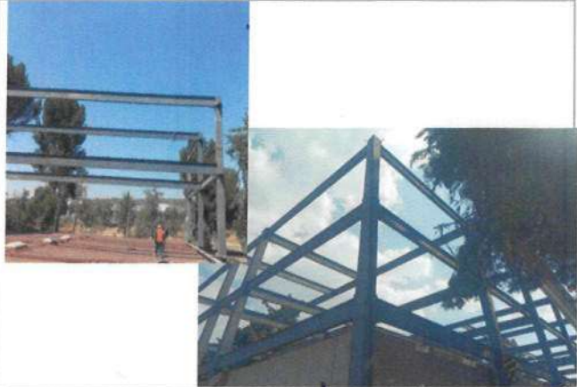
FOTOGRAFIA 3 (F3). Azotea edificio existente, estado actual estructura de acero en losa de planta baja y estructura de acero (vista Noroeste).
