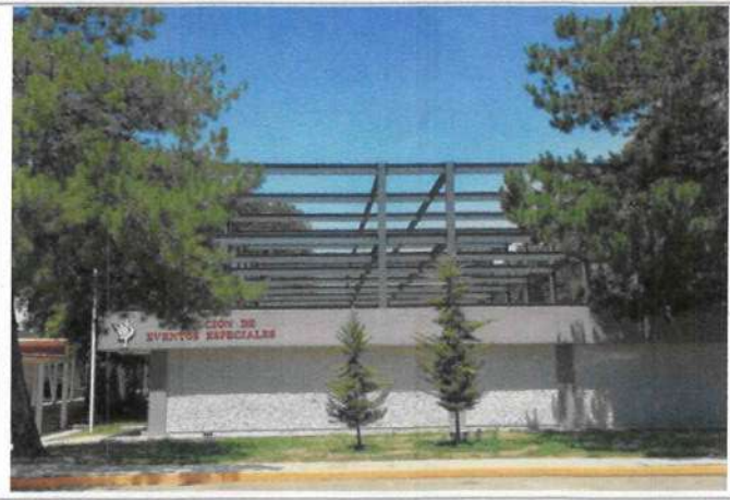
FOTOGRAFIA 2 (F2). Fachada Noreste (condiciones actuales del edificio).
