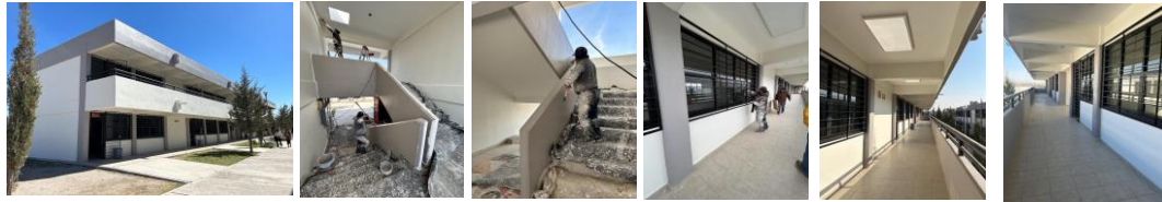
Fotos: Continuación trabajos de pintura y limpieza general de obra
