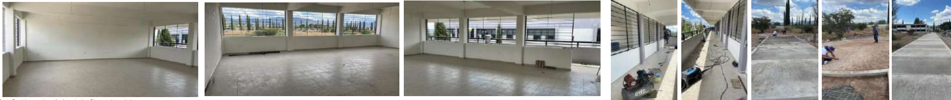
Fotos: Suministro y colocación de acabados; Obra exterior: andadores
