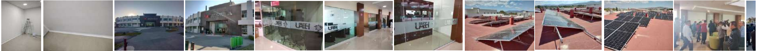
Fotos finales, obra concluida.
