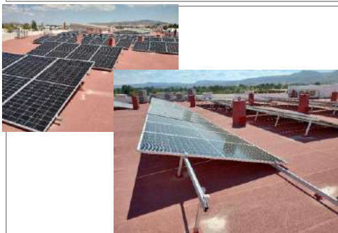
FOTO 3: Suministro y colocación de paneles solares
