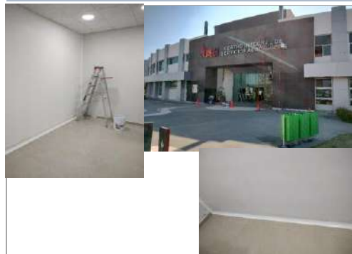
FOTO 1: limpieza de la obra
