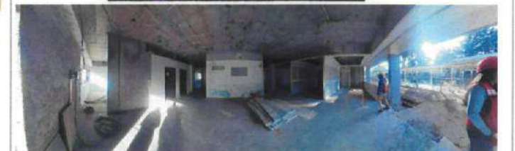
FOTOGRAFÍA ANTES, DURANTE Y DESPUÉS. Exterior del módulo intervenido. Interior Pasillos centrales.
