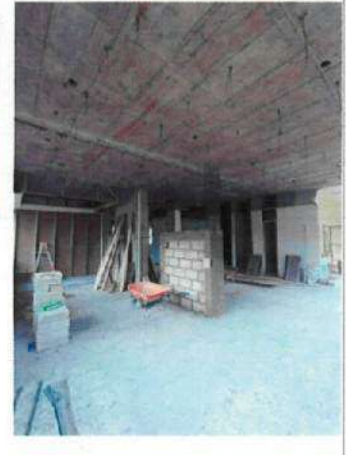
FOTOGRAFÍAS 2 (F2). Desplante de muros de block, suministro y colocación de muros divisorios.
