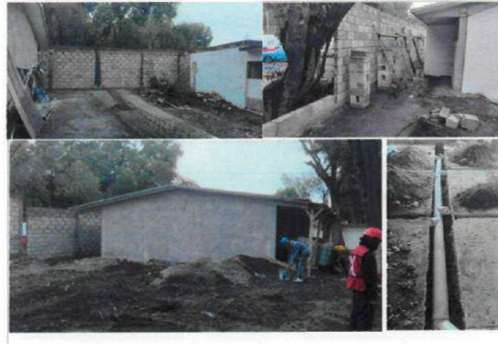
FOTOGRAFÍAS 2 (F2) Construcción de barda, inicio trabajo de repellos en exteriores e implementación de instalaciones hidrosanitarias
