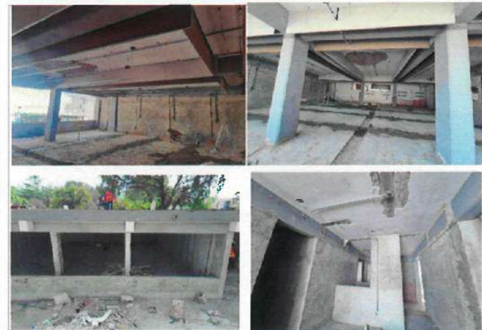
FOTOGRAFÍAS 3. (F3) Trabajos en interiores: implementación y preparación para instalaciones hidrosanitarias y eléctricas.
