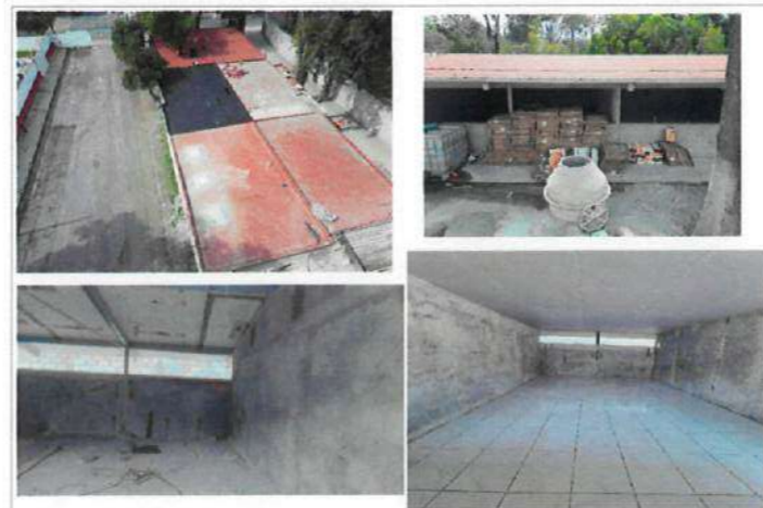
FOTOGRAFÍAS 4. (F4) repellos interiores, colocación de pisos y trabajos de impermeabilización.
