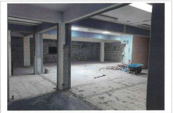
FOTOGRAFIA ANTES, DURANTE Y DESPUÉS. Interior Edificio "1"
