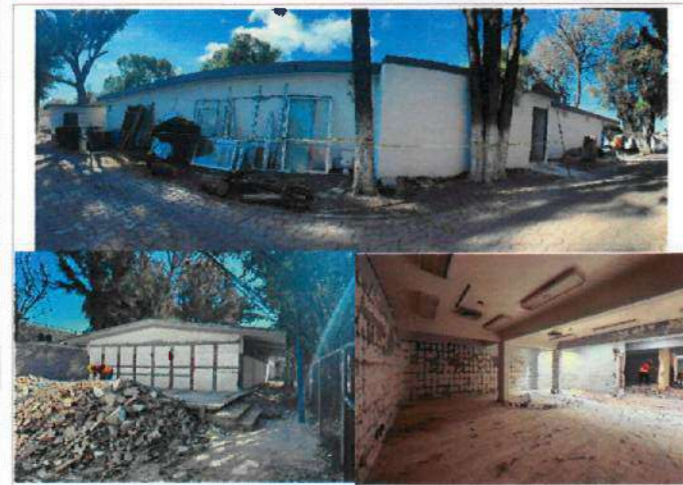
FOTOGRAFÍAS 1 (F1). Demolición y remoción de acabados, pisos, instalaciones existentes.
