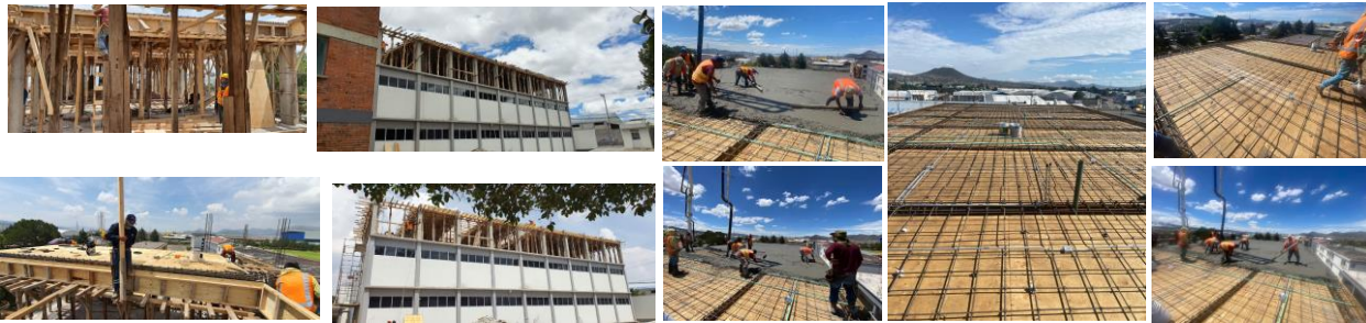
OBRA: Habilitado de cimbra y acero de refuerzo; colados de concreto en 50% de la superficie total del edificio e
