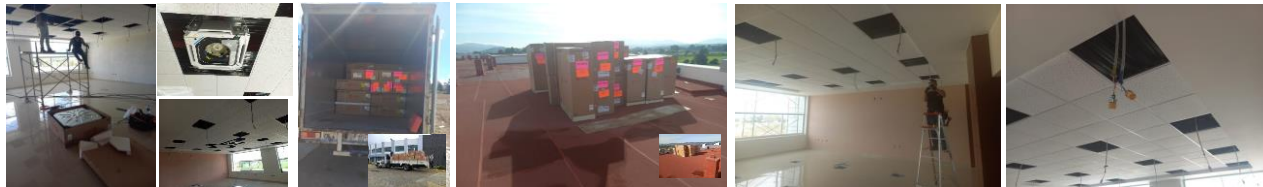
Suministro y colocación de: equipo de aire acondicionado y lámparas interiores
