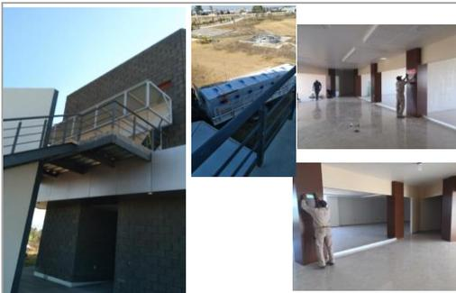
FOTO 4: Suministro y colocación de señalética; acabados: forrado de alucobond en vigas y columnas
