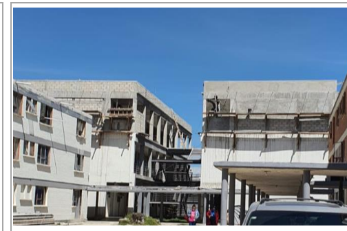
FOTO 5: Avance de los trabajos
