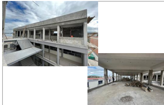
FOTO 4: Repellado de muros exteriores, pretiles y limpieza de obra
