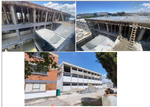
FOTO 1: Trabajos de habilitado, cimbrado y colado de concreto en la segunda losa,
