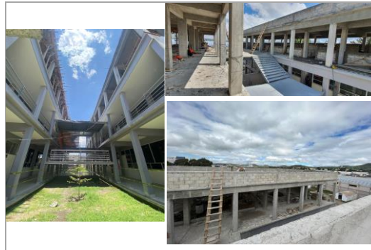
FOTO 2: Avance de los trabajos en el módulo de edificios atendidos.
