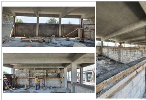
FOTO 3: Construcción de muros de block interiores, repellados y cadenas de cerramiento
