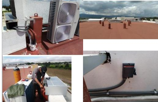
FOTO 4: Trabajos de ducterías y acometidas eléctricas, suministro y colocación de equipos condensadoras de Aire Acondicionado tipo cassette, minisplit en azotea.
