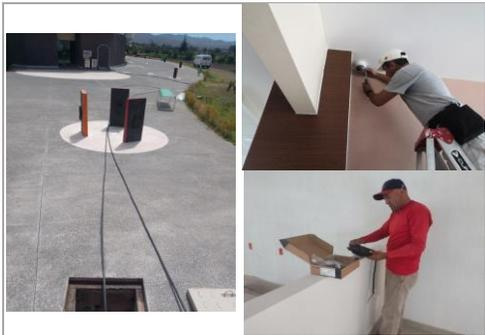
FOTO 3: Suministro y colocación de fibra óptica, desde el edificio J al site de nivel 2. Suministro y colocación de cámaras de Circuito cerrado y equipos telefónicos del sistema de telecomunicaciones.
