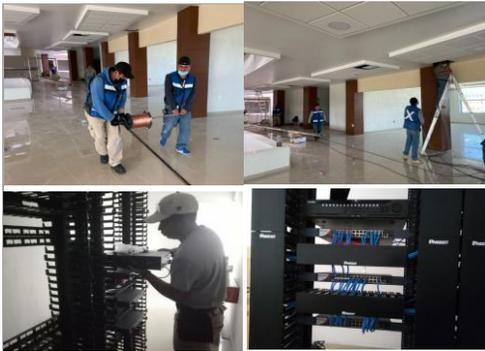
FOTO 1: Trabajos de cableado para acometida eléctrica para equipos de aire acondicionado tipo cassette de las áreas condensadoras de azotea. Suministro y colocación de equipo de telecomunicaciones y Circuito cerrado.
