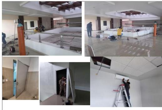
FOTO 2: Trabajos relativos a la fabricación de barandales y pasamanos, suministro y colocación de puertas en sanitarios y área de servicio; suministro y colocación de equipos de Aire Acondicionado tipo cassette, minisplit.
