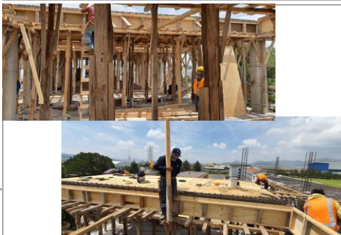
FOTO 3: Habilitado de cimbra y acero de refuerzo.
