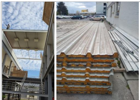
FOTO 1: Preparación de superficie de trabajo: Desmontaje de cubierta en módulo de escalera.
