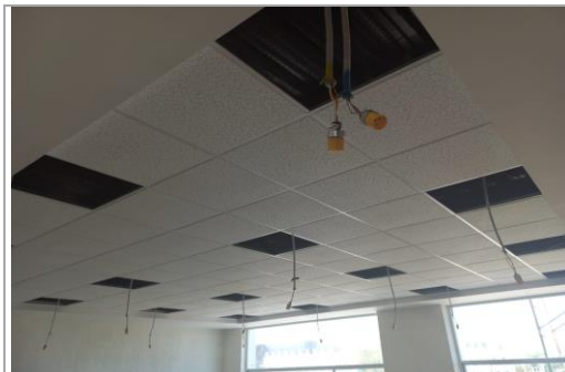
FOTO 2: Colocación de lámparas en espacios interiores
