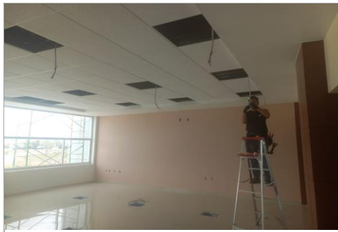
FOTO 1: Colocación de lámparas en espacios interiores
