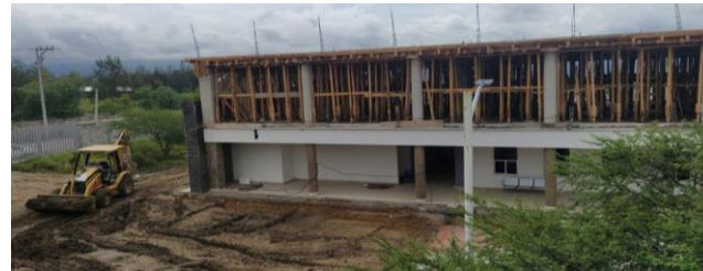
Movimiento de tierra y conformación de plataforma para ampliación de plaza cívica.
