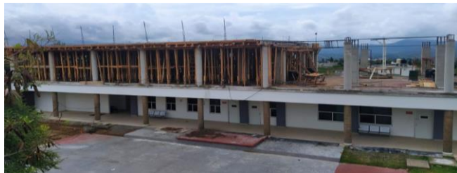
Se concluye trabajo de colado en columnas y cimbrado para colado de losa
