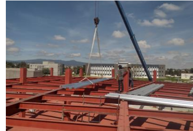
FOTOGRAFÍAS: Suministro y colocación de estructura de acero, losacero y preparaciones para colado de losa.
