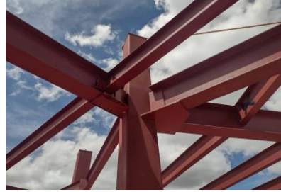
FOTOGRAFÍAS: Suministro y colocación de estructura de acero, losacero y preparaciones para colado de losa.
