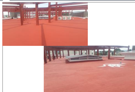
F4: Ampliación de metas: Desplante de estructura metálica para nivel 2 de edificio. (metas ampliadas con inversión autorizada de "ampliación recursos estatales" de Gobierno del Estado con cargo al Fondo de Aportaciones Múltiples)
