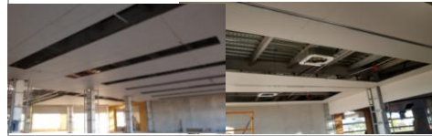
F1: Suministro y colocación de plafones lisos en interiores
