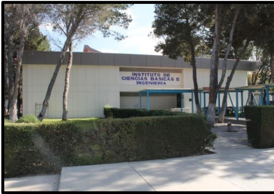
Edificio A recién pintado.
