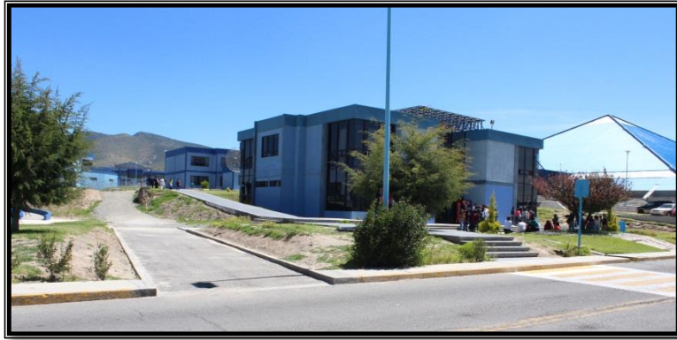
Pasillo de acceso al edificio D y F
