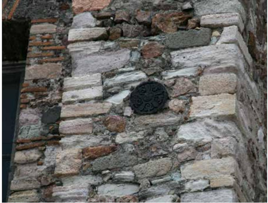
**L**os muros de este monumento histórico con trescientos años de antigüedad fueron realizados con mampostería, asentados con diferentes morteros; en algunas partes inferiores, mediante lodos con mezclas, y en las superiores, con cal y rocas extraídas de las minas; se distinguen, además, algunos sillares de cantera.
